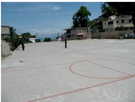
Le toit du réservoir, vue vers la mer
